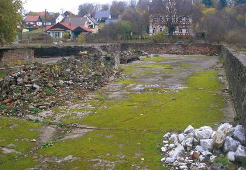
Ruine der Küchenbaracke im ehemaligen Lager Ellrich-Juliusshütte
