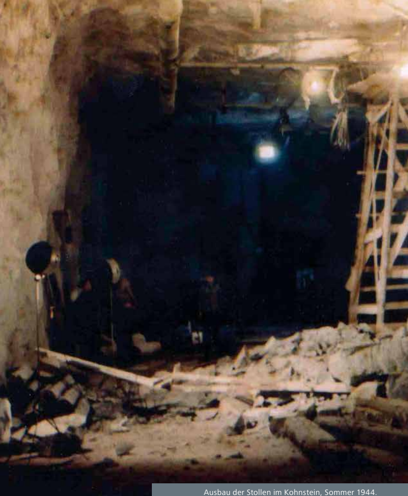
Ausbau der Stollen im Kohnstein, Sommer 1944.
